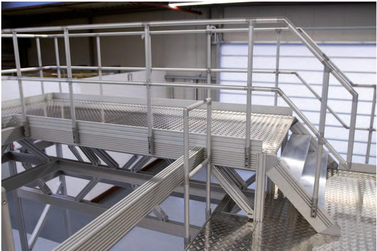
Treppenaufgang zwischen zwei Arbeitsplattformen
